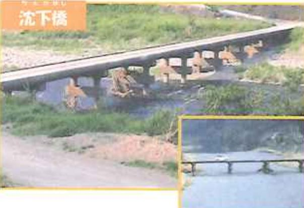
沈下橋とは、大水のときに水面下に沈むように作られた橋のことで、流木などがひっかかって壊れるのを防ぐため、水の抵抗をうけないシンプルな形になっている。橋のらんかんがなく、嵩さも低いのが特長。
